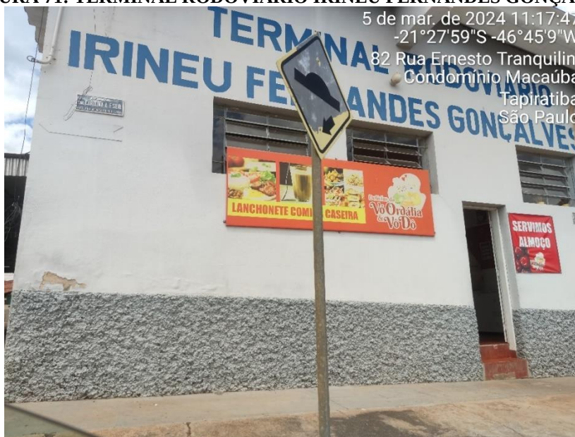
FIGURA 71: TERMINAL RODOVIÁRIO IRINEU FERNANDES GONÇALVES.
