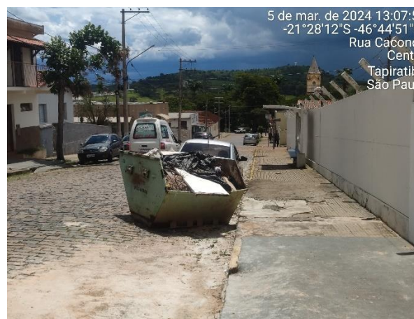
FIGURA 63: CAÇAMBA PARA O ACONDICIONAMENTO DE RCC.
