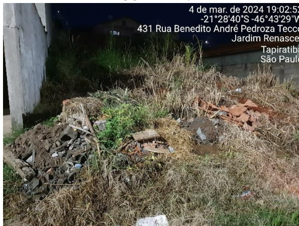
FIGURA 64: RCC DISPOSTO DE FORMA INCORRETA.
